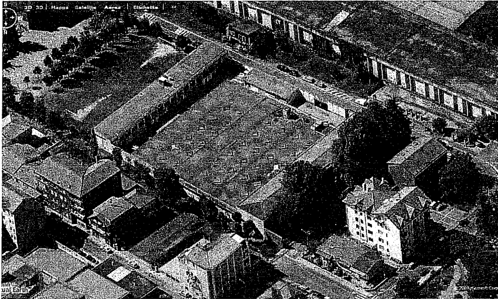
Vista aerea nord-ovest
